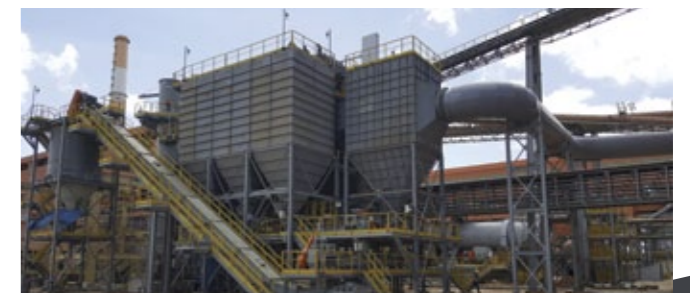
포스코 건설 CSP제철소 코크공장
